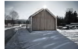
Kleinwasserkraftwerk Fuschler Ache Thalgau 2011
