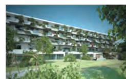
Construcción de viviendas Grüne Mitte Linz Linz 2013
