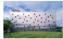
Entrepôt atelier Wallner Scheifling 2005
