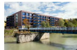
foyer pour personnes âgées Hallein 2013
