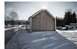
centrale hydroélectrique Fuschler Ache Thalgau 2011
